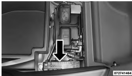
Centrale de servitudes arrière
